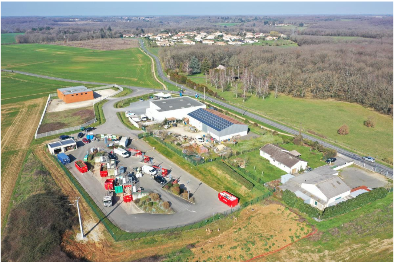
La zone des Erondières avec la déchetterie communautaire de Ligugé, vues en direction du nord-ouest, avec à droite la RD 87 et en bas le Fief du Pilier. Photographie Mairie de Ligugé.
