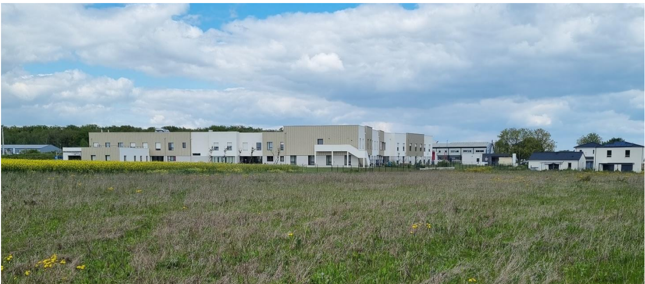
Les paysages ruraux ont été remplacés par des ambiances plus urbaines au nord-ouest du site nord ; ici le nouvel EHPAD de Ligugé (zone des Erondières), en avril 2024.
