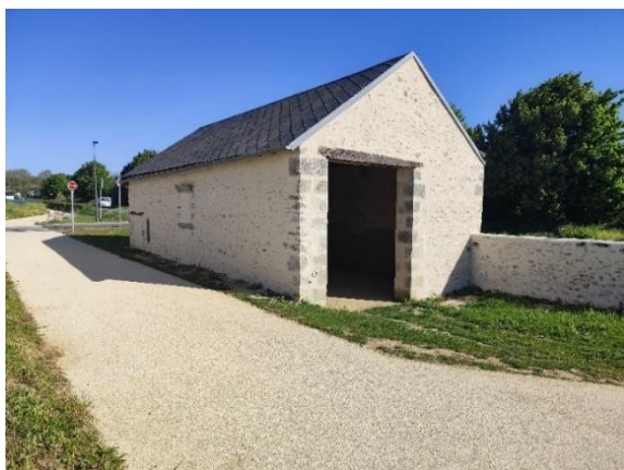
Grange restaurée, à l'est de la zone d'étude
